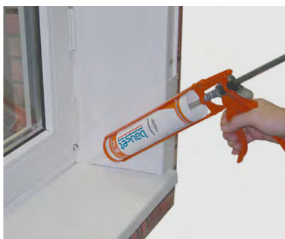
Герметизация швов при установке откосов
