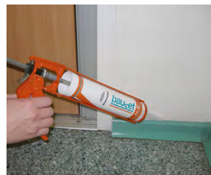
Герметизация швов в общественных работах
